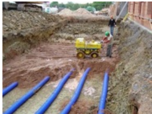
Ensemble immobilier - Pose de collecteurs géothermiques
