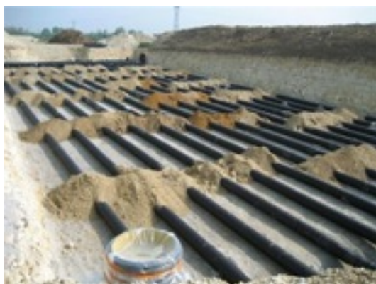
Montage de tubes et regards intermédiaires
