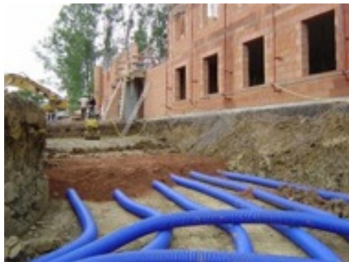
Ensemble immobilier - Pose de collecteurs géothermiques
